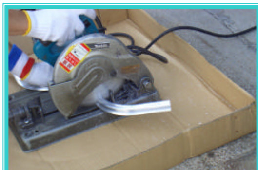
カッターによる曲げ加工
