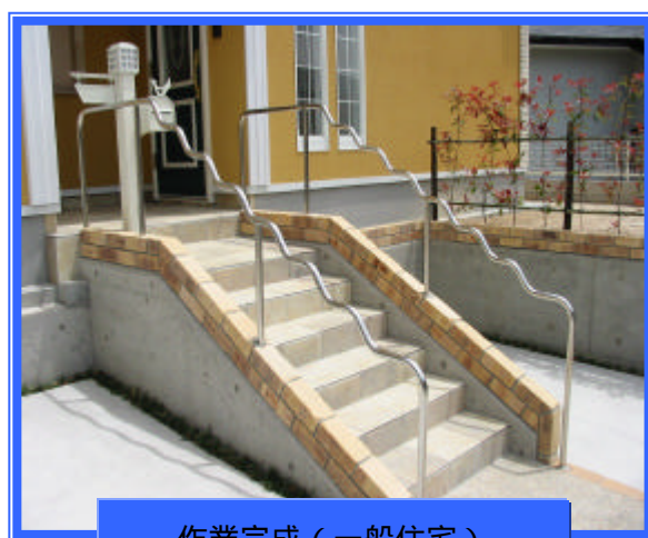
作業完成 (一般住宅)
